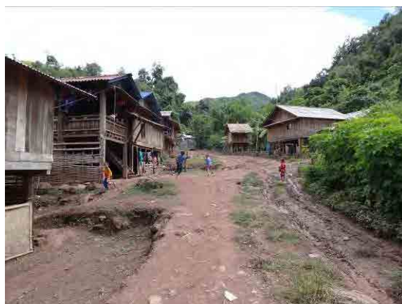
写真－９：配電線延伸対象の未電化村、クヌア村（西側地域）の状況。
