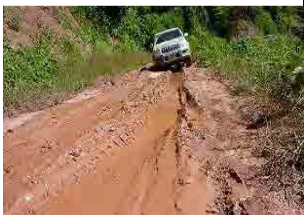
写真－１１：配電線延伸地域へのアクセス状況。雨期には車両の通行が困難であるため、乾期での施工が求められる。
