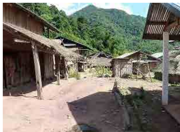
写真－１０：配電線延伸対象の未電化村、カン村（西側地域）の状況。
