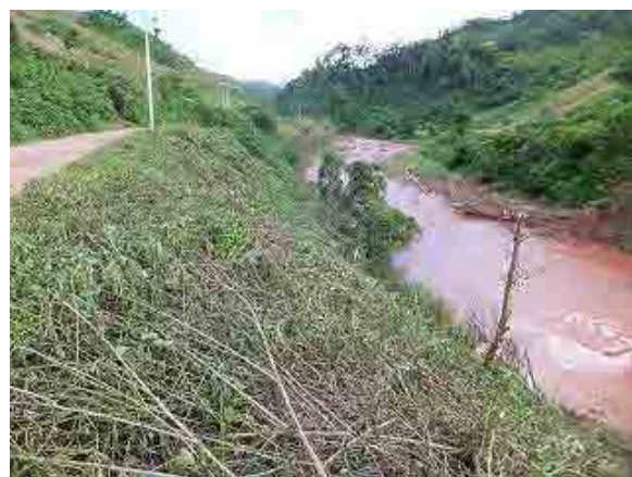
写真-4：小水力発電所の水路経過予定地を上流側から撮影。既設道路と河川の間の斜面にコンクリート開水路を設置予定。
