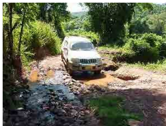
写真－１２：配電線延伸地域へのアクセス状況。雨期には車両の通行が困難であるため、乾期での施工が求められる。
