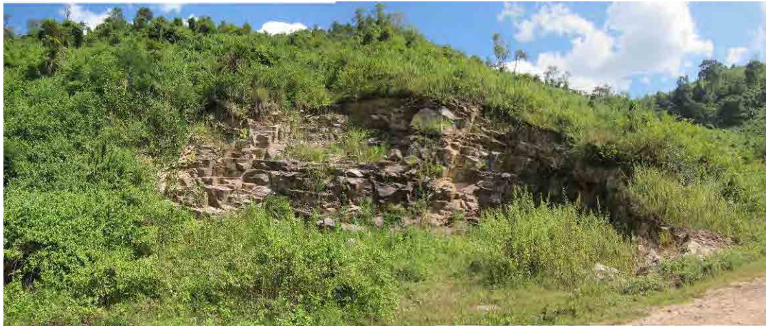
写真 2-17 原石山候補地全景
