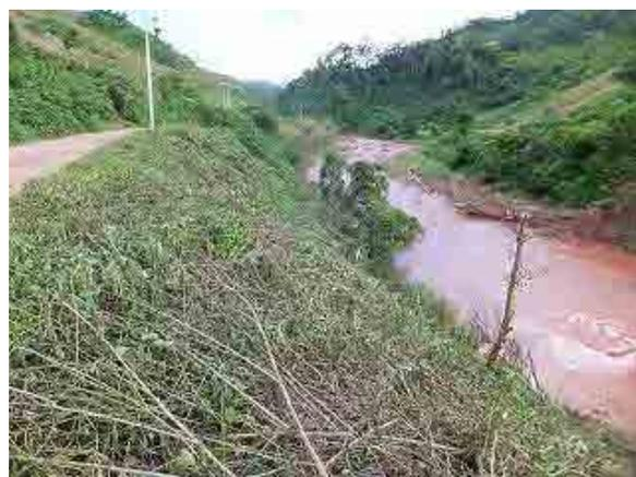
写真－４：小水力発電所の水路経過予定地を上流側から撮影。既設道路と河川との斜面にコンクリート開水路を設置予定。
