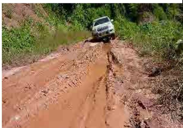
写真－11：配電線延伸地域へのアクセス状況。雨期には車両の通行が困難であるため、乾期での施工が求められる。
