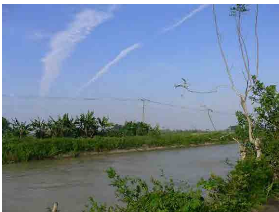
写真-5：サイト近傍にはすでに13.2kV配電線が敷設されており、サイト近隣の水力発電所と69kV変電所が連系されている。プロジェクトではこの配電線に接続する計画である。
