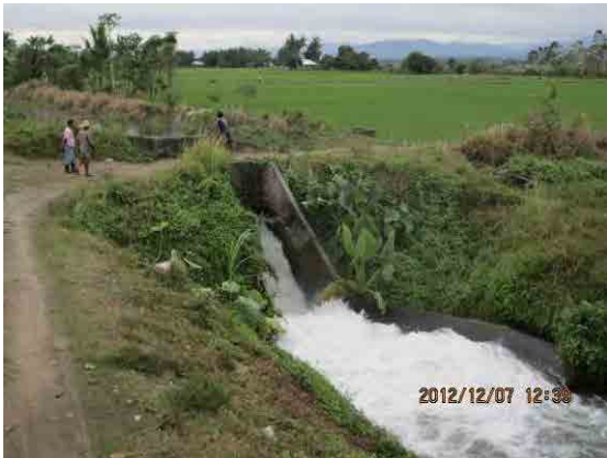
写真-3：既設落差工下流側。約3mの水位差があるが、そのポテンシャルは利用されていない。プロジェクトではこの両側に簡易水車を設置する計画である。
