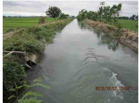
写真-2：既設灌漑水路は灌漑システムにより流量調整されており、断水期間の約1ヶ月を除いて流量は安定している。
