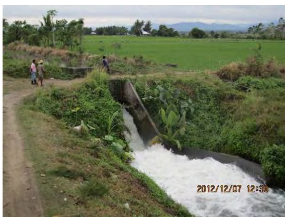
写真-3：既設落差工下流側。約3mの水位差があるが、そのポテンシャルは利用されていない。プロジェクトではこの両側に簡易水車を設置する計画である。
