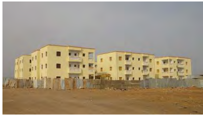
PK12 地区西部
