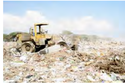
ランドフィルコンパクターによる圧縮と破碎
