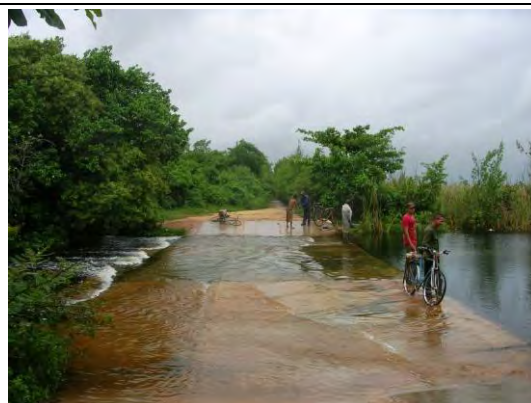
対象地域に建造されている 地下水涵養ダムの越流部
