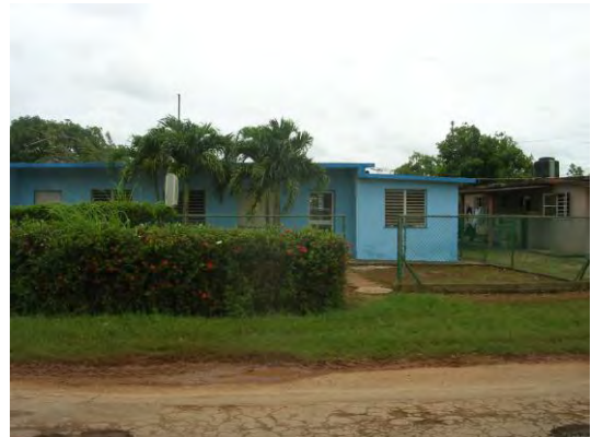
プロジェクトオフィス候補 (キビカン) GEARH が管理する施設
