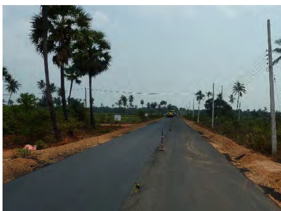
写真 2e: 幹線道路改修工事
