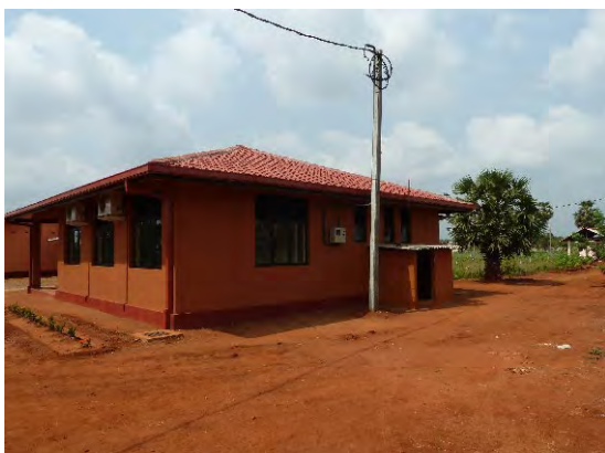
写真 2c : 電線の引込
