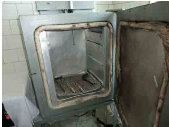
ハترون州病院 滅菌器 老朽化により、温度調整ができない。
