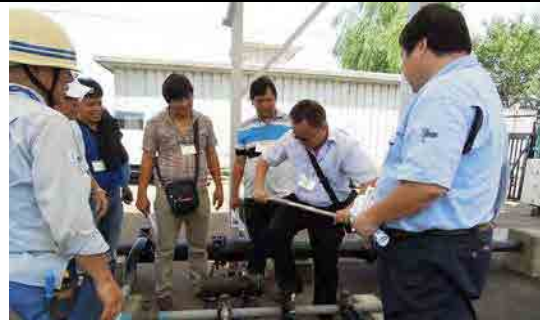
[配 08] 配水管・給水管修理 (7/27)
