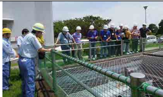
[共 05] 浄水場の運転・維持管理 (7/25)
