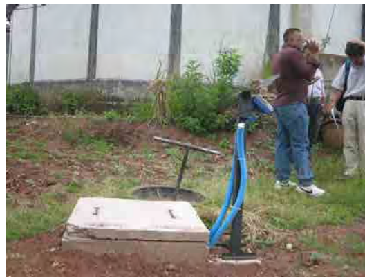
スペイン納入の流量計(正しい表示をしていないと思われる)
