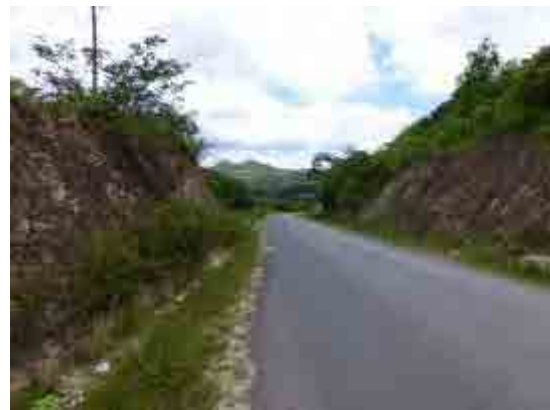
写真 3-2.3 一般道路部 切り取り法面状況
