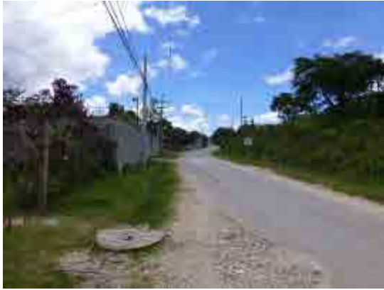
写真 3-2.4 一般道路部 平地部状況
