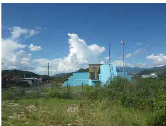
写真 2-2.1 コンセプション発電所建設予定地 (青色の構造物はエアレータ)
