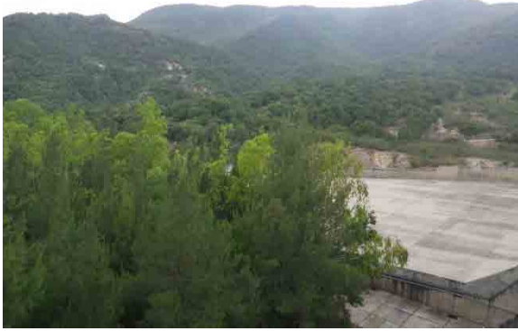
写真 2-2.3 コンセプションダム上流
