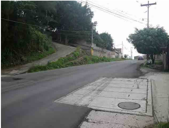
既存の減圧バルブピット
