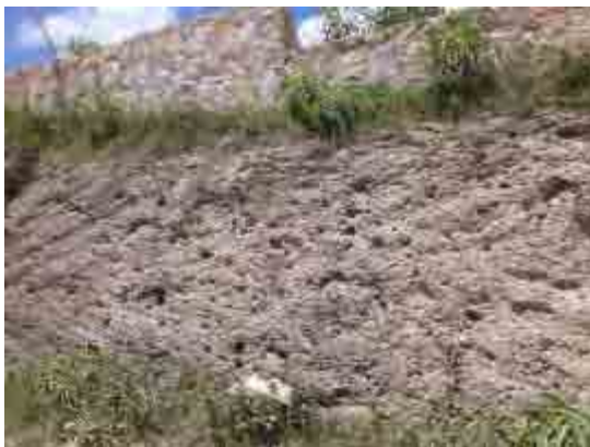
写真 3-2.2 エアレーター付近道路斜面状況
