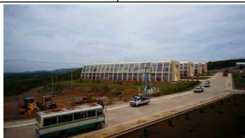
大学の校舎は未だ建設中
