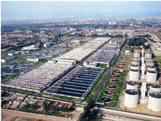
北京市高碑店処理場 (処理能力 100 万 \text{m}^3 /日) 全景
