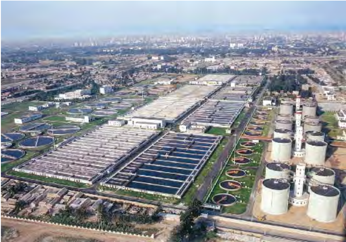
高碑店処理場の写真（左から 最終沈殿池・反応槽・最初沈殿池・濃縮槽・消化槽）
