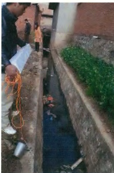
汚水管に接続する開渠
