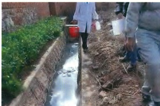
汚水管に接続する開渠（汚泥沈殿）
