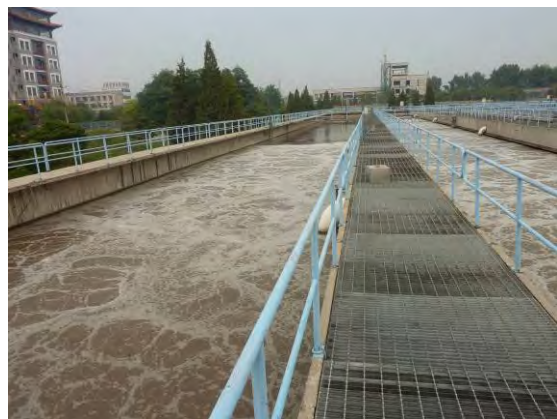
北京市高碑店処理場 反応槽 (嫌気・好気法 左側の槽の奥が嫌気部分、手前が好気部分)
