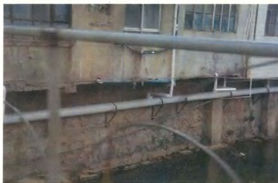
河川側は下水管による汚水の取り込み
