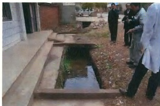
道路側は従来型の水路への雑排水の流出
