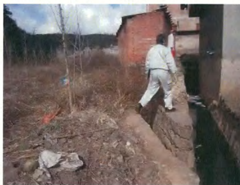
汚水管に接続する開渠（汚泥沈殿）
