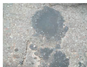
同左、ポットホールの補修はコールドアスファルトを埋めただけ
