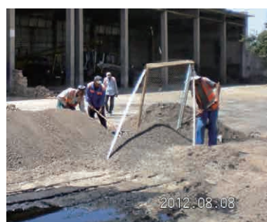
シャリナフ事務所, 人力による砂のふり分け作業
