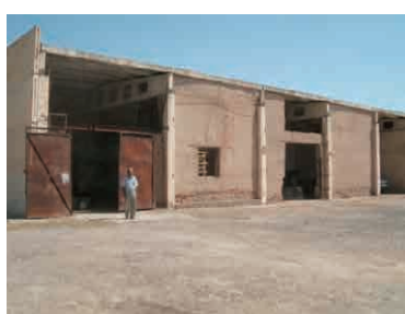
同左、駐機場、倉庫建物
