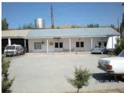
ファイザバード事務所、中国業者が施工時に使用していた事務所をそのまま使用
