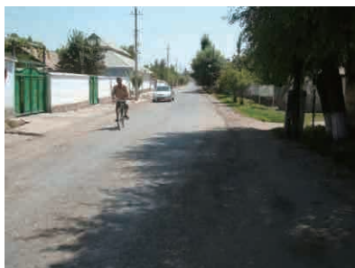
ジョミ事務所管内の地方道路 事務所単独で施工（グレーダと被牽引式ローラだけ使用し施工された）
