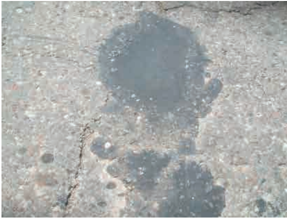
コールドアスファルトにて 修理したポットホール状況
