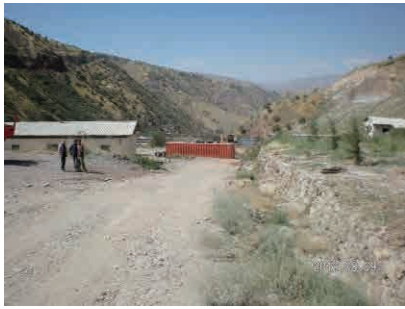
ヌレック事務所，中国業者が施工時に使用していた事務所へ引っ越す予定。 Shar-Shar トンネル坑口付近
