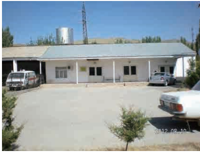
ファイザバード事務所，中国業者が施工時に使用していた事務所をそのまま使用
