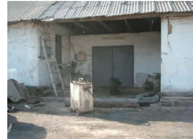
整備機材設置予定場所 (3相電源あり)
