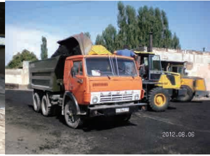
ホイールローダによるコールドアスファルトのダンプへの積み込み
