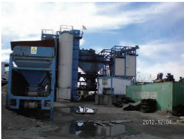
ヒッサール管理局 A/P設置予定地現況 (撤去予定の中国企業のA/P)
