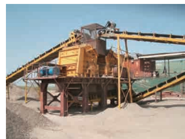
同左、クラッシャープラント (アスファルトプラントまで15 km)
