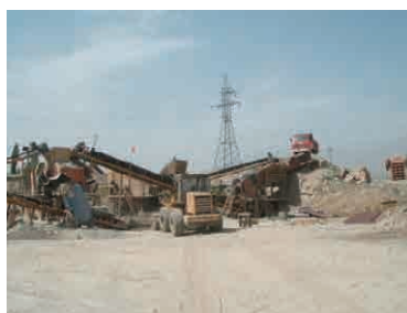
同左、骨材プラント
