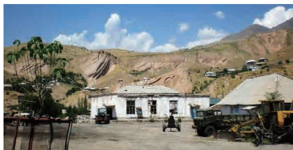
バルゾフ事務所のヤード
