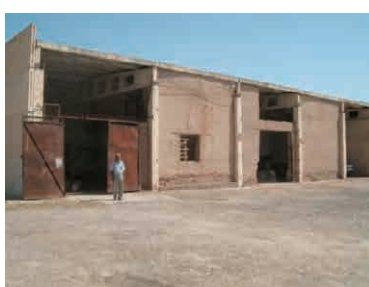
同左、駐機場、倉庫建物
