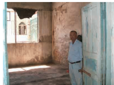
整備機材設置予定の部屋、施錠 可能
