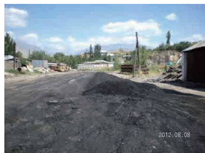
ツルサンザーデ事務所，コールドアスファルト製造
