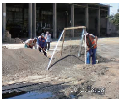
シャリナフ事務所，人力による砂のふるい分け作業
