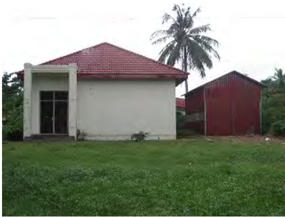
検査棟(U棟)及び倉庫。右手にサービス棟建設予定。
