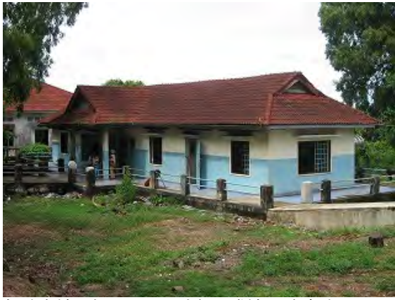
内科病棟。右手スロープ先の隣棟に診察室がある。
