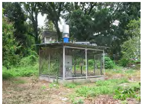
我が国一般プロジェクト無償による焼却炉
