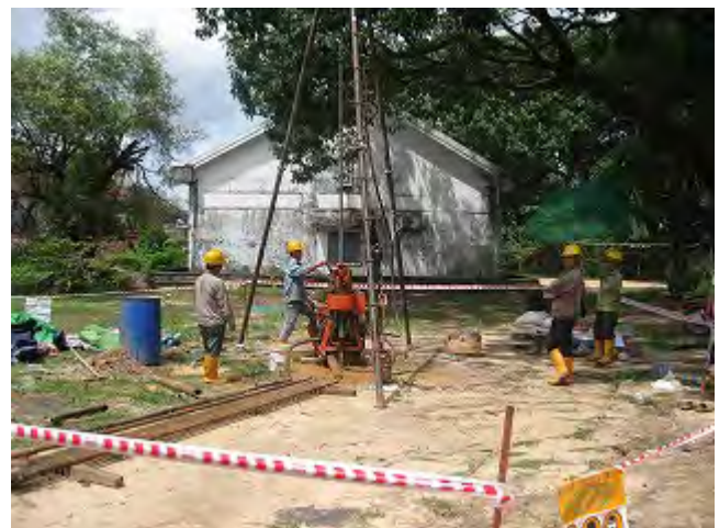
ボーリング調査
