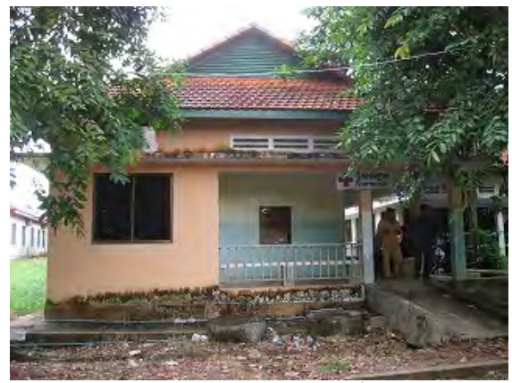
薬局(X棟)。建設後に移転、OD薬品倉庫になる予定。
