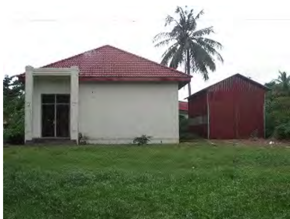
検査棟(U棟)及び倉庫。右手にサービス棟建設予定。
