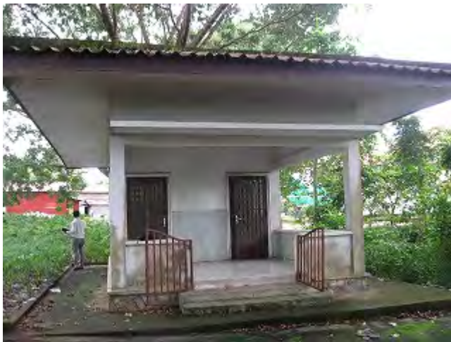
撤去予定の霊安室棟(F 棟)
