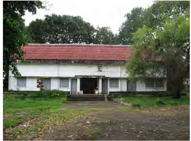
撤去予定の OD 薬品倉庫(E 棟)
