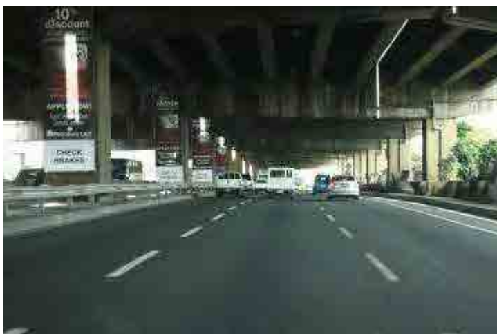
図 2-5 SLEX (階下) と SKYWAY (階上)
