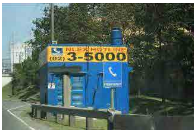
図 3-3 NLEX 上の非常電話施設 (1)
