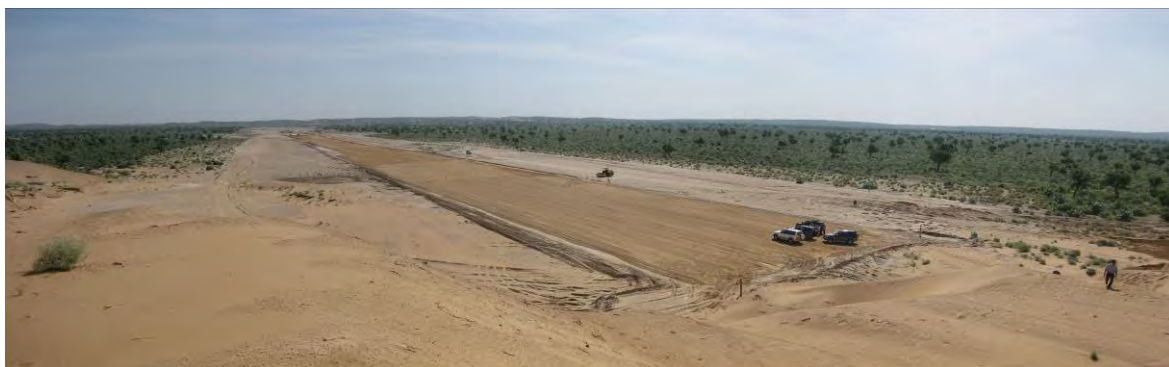
写真 5.5-1 タール空港(建設中)
