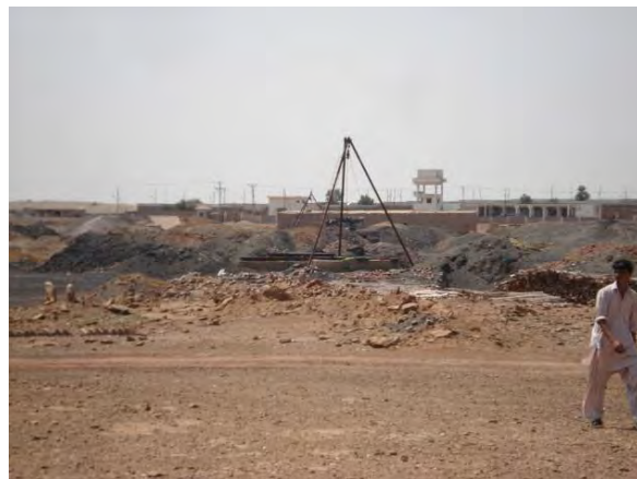
写真 2.3-2 ラクラ炭田 縦坑
