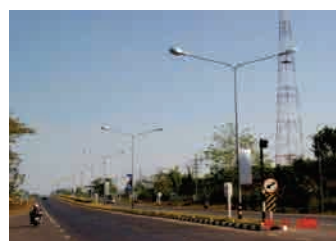
幹線道路における照明設備
