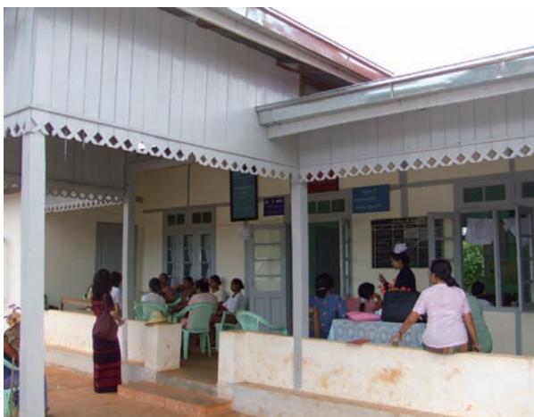
プロジェクトで改修した Bant Bwe Rural Health Center にて (ナウンチョータウンシップ)
