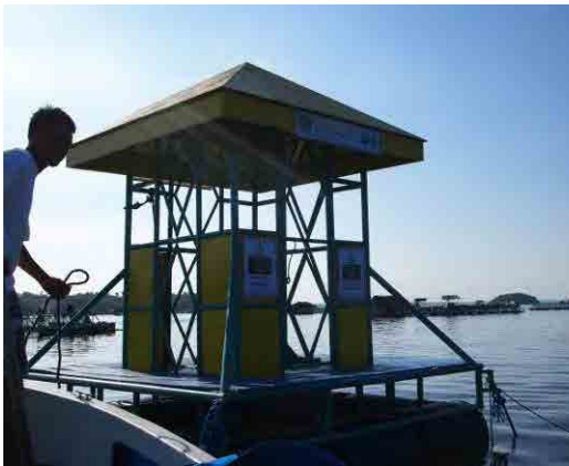
Bolinao サイトの CCMS (浮体部)
