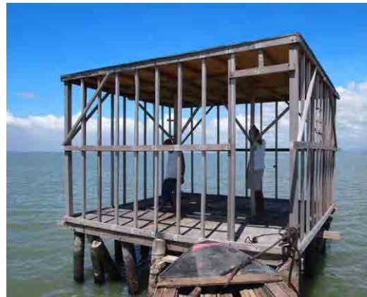
Lagna Lake サイトの CCMS (仮設の上部構造と杭)
