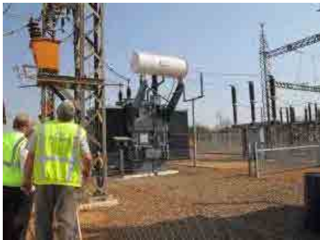
(a) 交流変電所用変圧器
