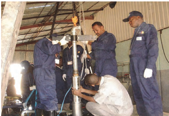
写真-5 井戸改修研修
