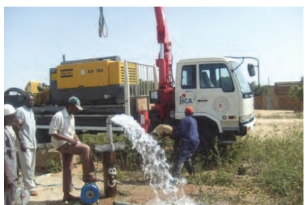
写真-6 井戸改修施工
