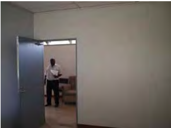
暗室に改造予定のラボ
