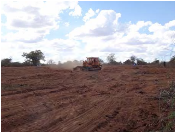
トラクターによる前植生木の除去
