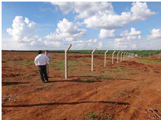
フェンスのコンクリート柱
