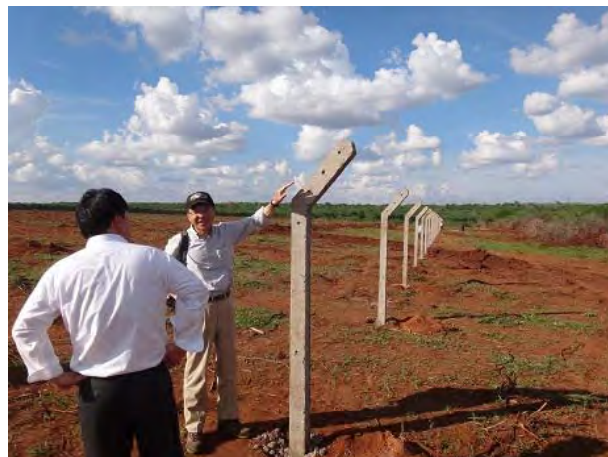
コンクリート柱の高さは2m
