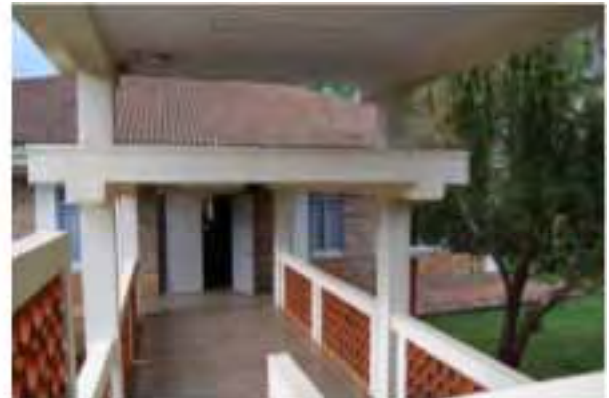
写真24 副所長の居室等と結ぶ渡り廊下
