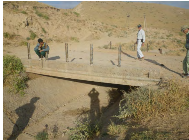
水圧管路ルートに架かる橋梁
