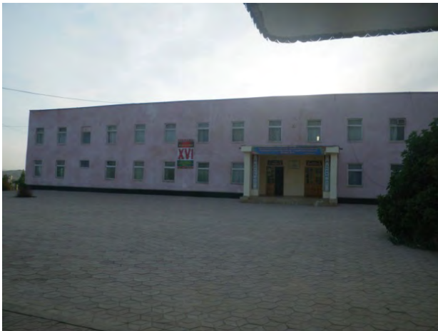
オクス村の学校 給電予定地であるオクス村にある学校である。
