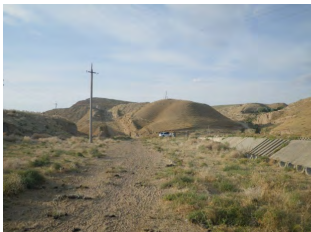
発電所サイト(上流から望む)
