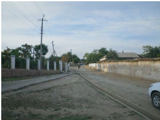
道路・配電網
