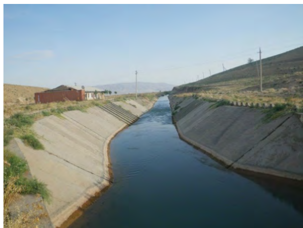
ヌルバクシュ用水路 (放水口設置予定地点)
