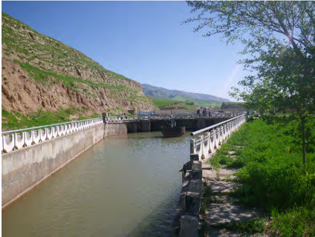
ダンガラ灌漑水路 分派池
