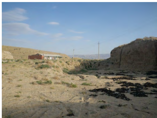
発電所サイト(上流から望む)
