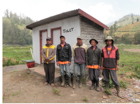
湖の堆積土砂が原料の日干しレンガで建設したトイレ プロモ・テンゲル・スメル国立公園
