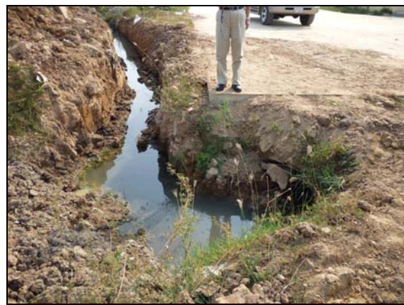
写真 7.5: Tai Seng Bavet SEZ Sub 下水放流状況（雨水管と共用）
