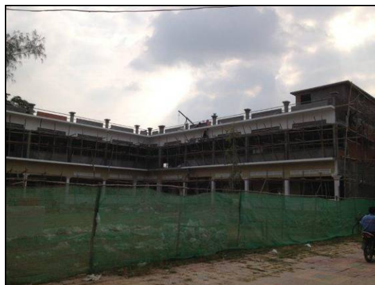
写真 9.4 : ADB 支援の建設中の訓練施設
