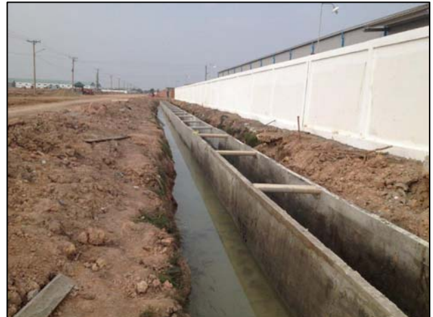
写真 7.3 : Manhattan SEZ 雨水排水用の側溝整備進行状況
