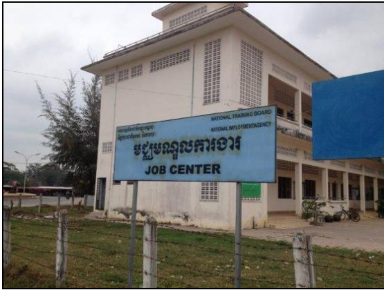
写真 8.1 : 「ス」州 Job Center の看板
