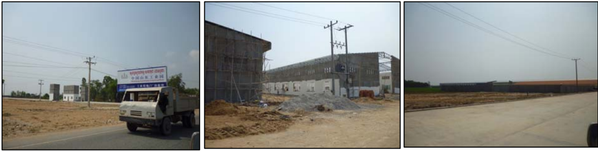
写真 3.6 : 工業団地 (Shandong Industrial Park) 開発状況写真
