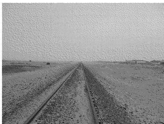
K 地点：線路の向こう（左側）は砂漠 盛土の上に線路が敷設されている。
