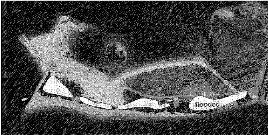
図-2.2.4(16) 冠水状況 (2012年7月22日7時頃)
