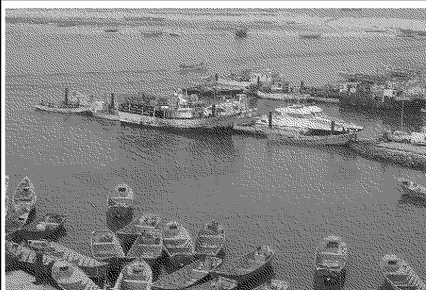
写真-2：荷捌場前の水揚棧橋 No. 1, No. 2
