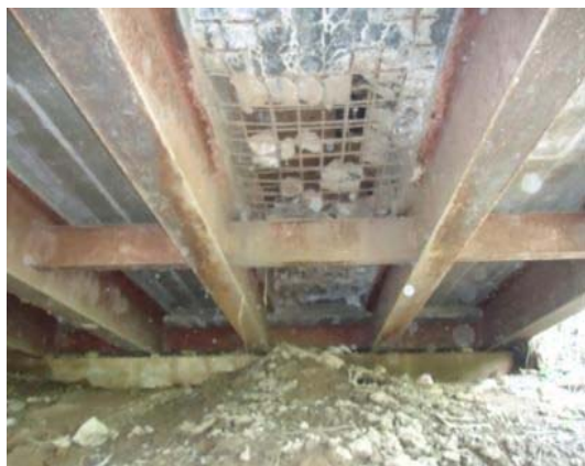
写真 3-1 国道 21 号線の橋
