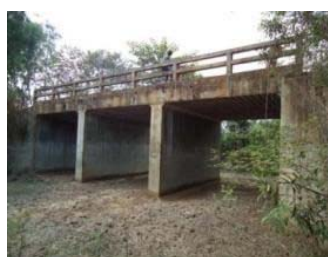
写真 3-5 ボックスカルバート
