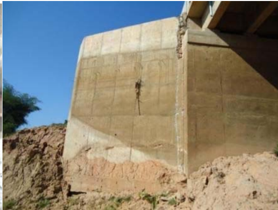
写真 3-2 国道 64 号線の橋
