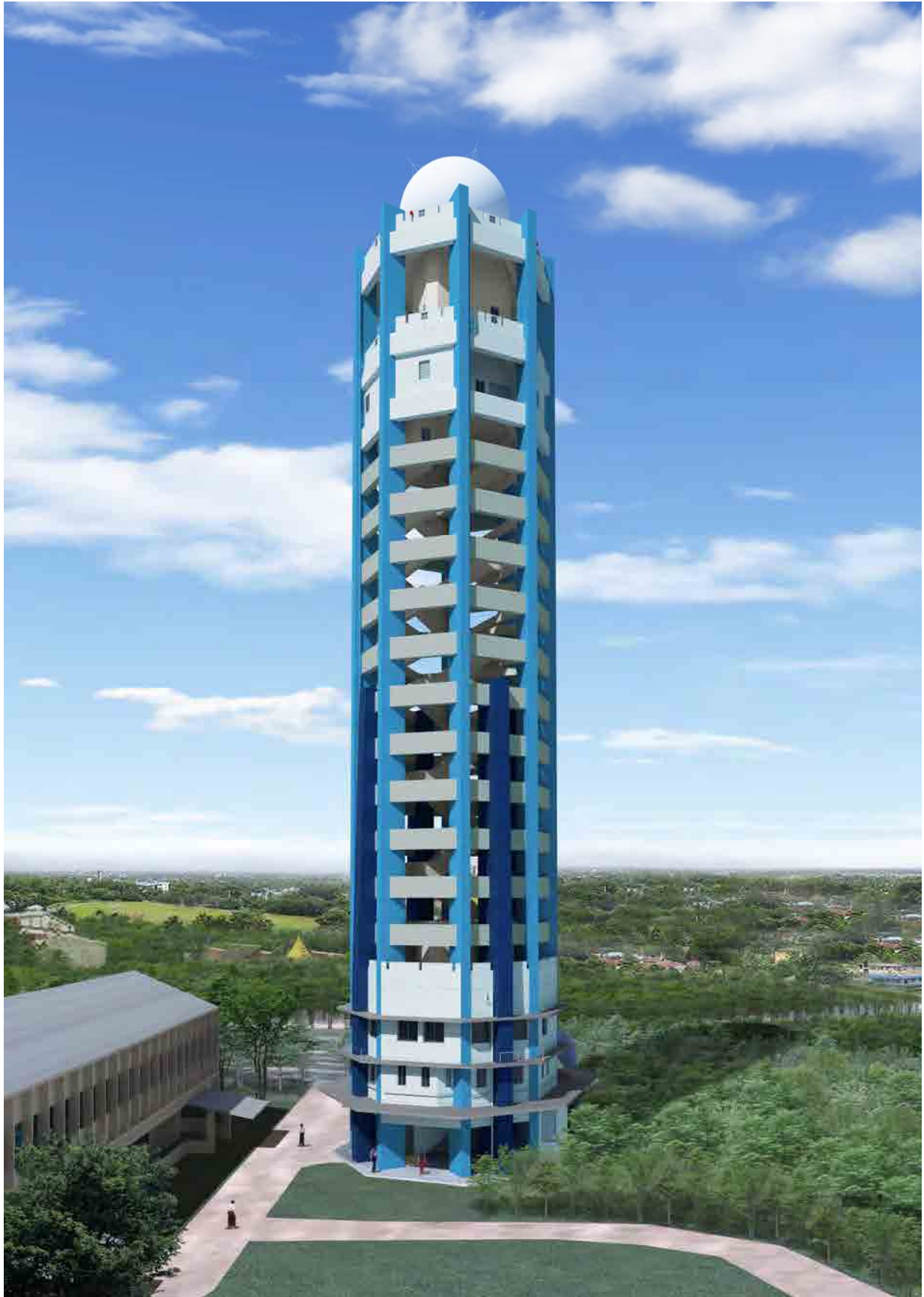
ヤンゴン気象レーダー塔施設
