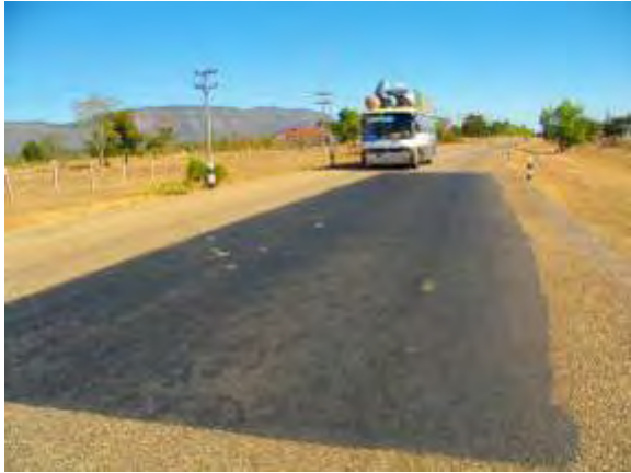
DBSTで補修した13号線(パクセ～サバナケット区間) DPWTから委託で業者が実施。
