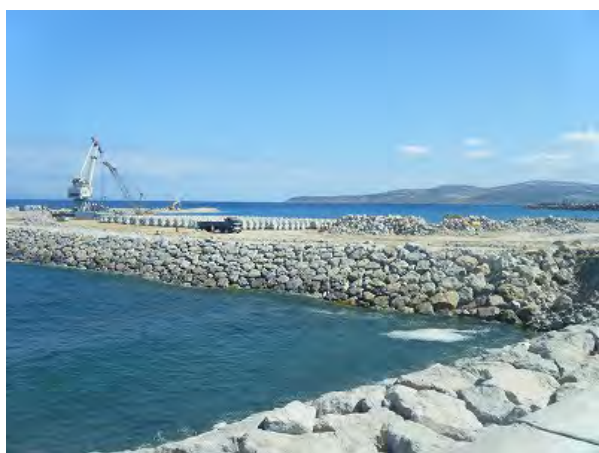
改修拡張工事中
