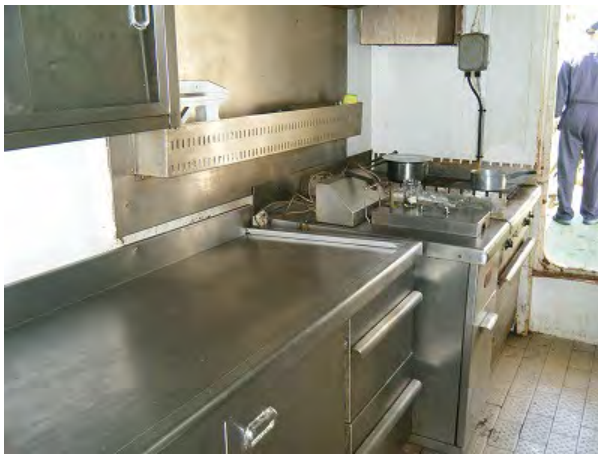
(CAI 号) 換装した調理室
