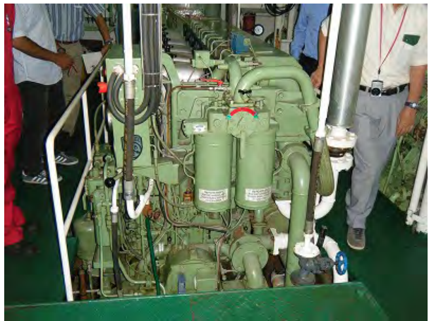
(CAI 号) 換装した主機関
