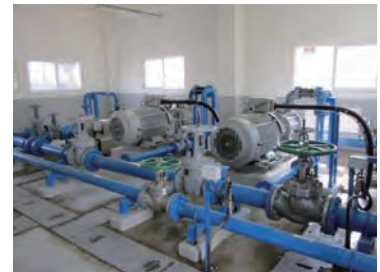
アダシアポンプ場
