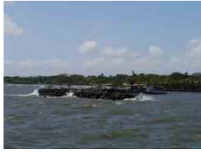
防波堤延長が短いため、堆砂が進み、浚渫が頻繁に必要
