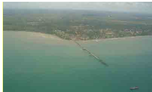
写真：プエルトカベサス港 （写真提供：EPN）
