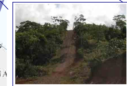
⑫ ナシオネス・ウニダス～ブルーフィールズ道路: 見返り資金により改良工事中である。
