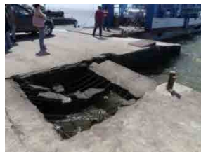
上部工舗装現況
