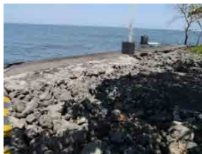
上部工舗装現況
