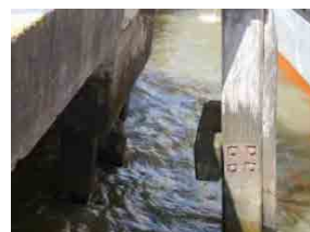
栈橋基礎の現況
