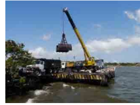
実施中の浚渫
