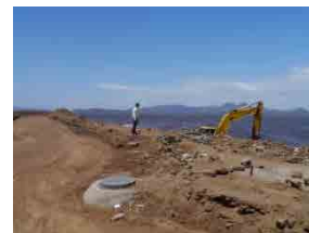
2 期工事建設現場
