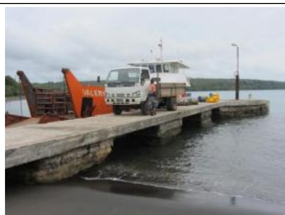
図 4-64 私有港湾施設(PRV)の全景
