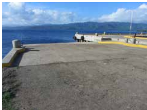
図 4-30 サブサブ埠頭 RORO 船が係留 (縦付け係留)される斜路
