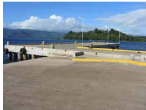
図 4-31 サブサブ埠頭に新設された係留埠頭
