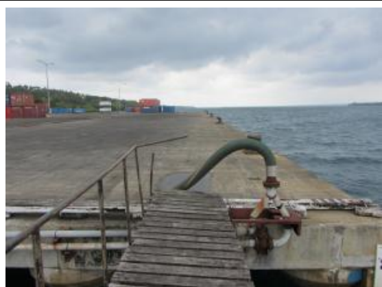
図 4-68 ルーガンビル港中央ふ頭（新設部分）
