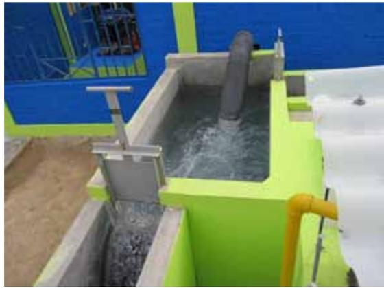
Captación. Construida en la salida del pozo y a su derecha se encuentra la toma para el tanque apoyado.
