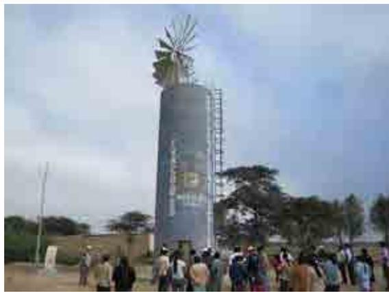
(Capilla Santa Rosa) El pozo y el reservorio forman una sola estructura integrada. La fuerza motriz de la bomba es un molino de viento.
