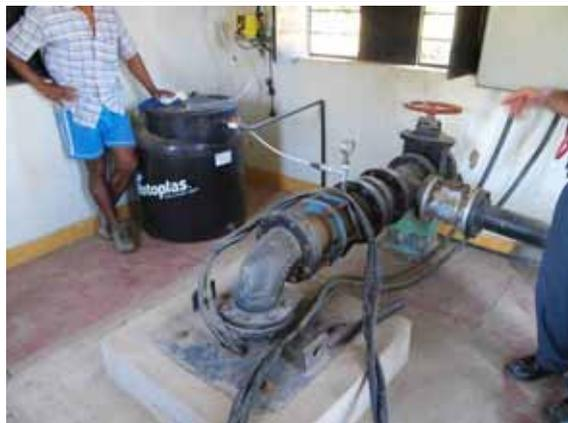
(Malacasí) Estado de la caseta de máquinas. La tubería de distribución que sale del tanque es nueva, pero hay problemas en la tubería de conducción.
