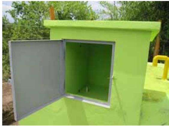
Caseta de cloración. Se instalará un tanque para el cloro que inyectará cloro al tanque apoyado, por goteo.
