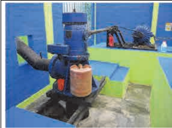
水源となる深井戸
