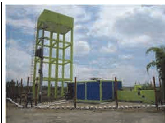
ポンプ小屋、取水施設、高架タンクの全景
