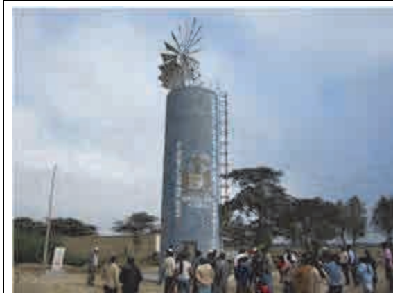
(Capilla Santa Rosa) 水源井戸と給水タンクが一体型。ポンプの動力は風車である。
