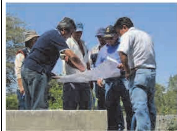
ウメダデス: 図面でバルブの位置を確認しその点検方法について説明をする
