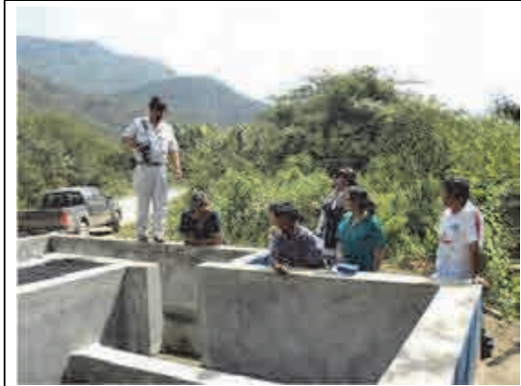
エル・エスピナル: 保険医は配属されたばかりなのでプロジェクトの概要説明と給水システムの説明を行った
