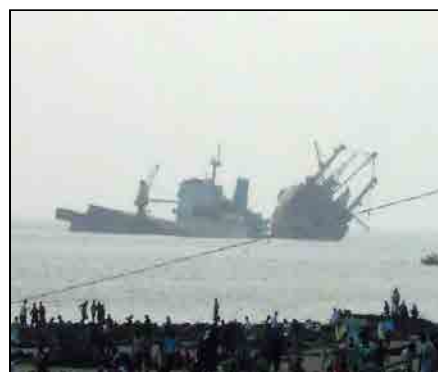
写真-1 浅瀬での廃船解体現場 (満潮時)
