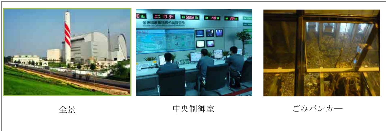
写真-3 高安屯ごみ焼却施設
