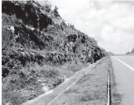
写真2 DIAに関する災害現場踏査
