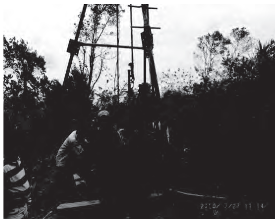
写真 21 モニタリング機材の設置
