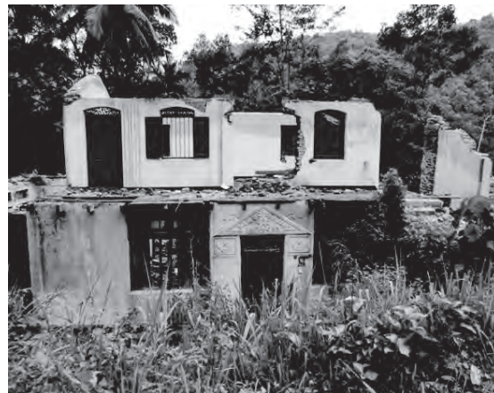
写真8 被災状況調査
