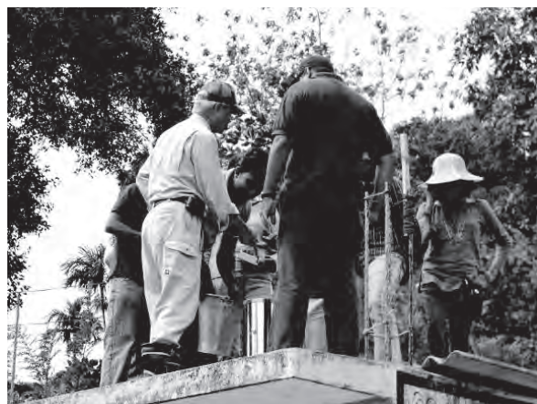
写真 22 モニタリング機材の設置
