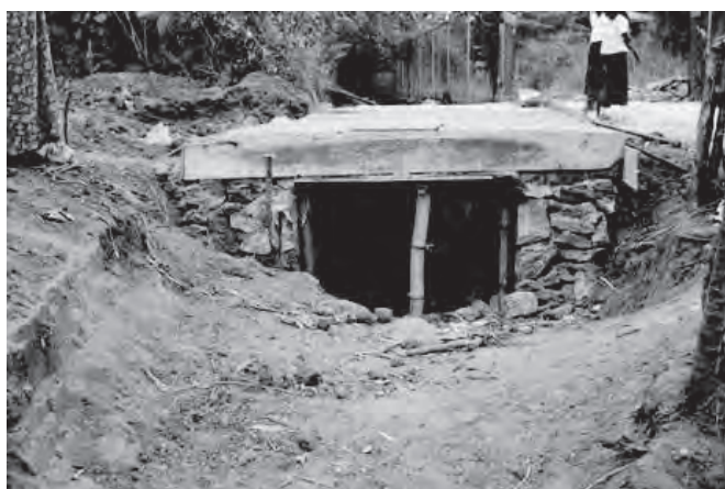
写真 33 コミュニティでの排水路整備（マータレ）
