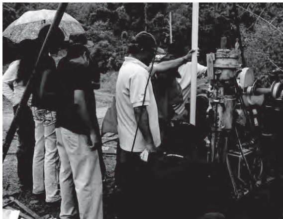
写真 19 モニタリング機材の設置
