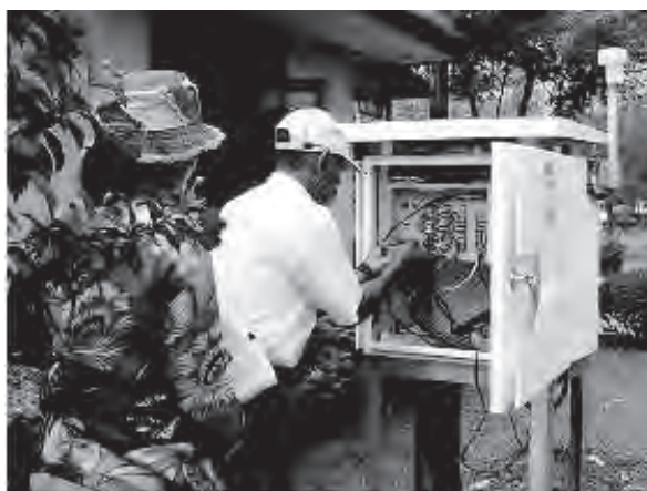
写真 17 観測機材の保守点検
