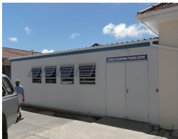
改修された Frere Hospital 研修室
