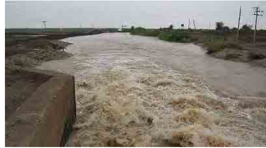
写真-8: ニューファルファ灌漑スキーム水路の状況 (K14ポンプ場掛り)
