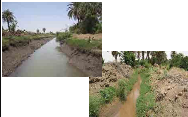
写真-7: キティアブスキーム水路の状況 (左上: 幹線水路、右下: 支線水路)
