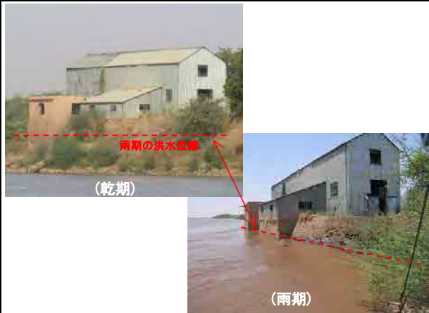
写真-2: キティアブポンプ場 乾期と雨期のナイル川の水位変動状況。水位差は約 7m 以上ある。
