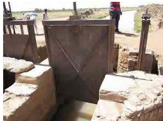
写真-12: 水路内施設 (調整ゲート: アリアブ)
