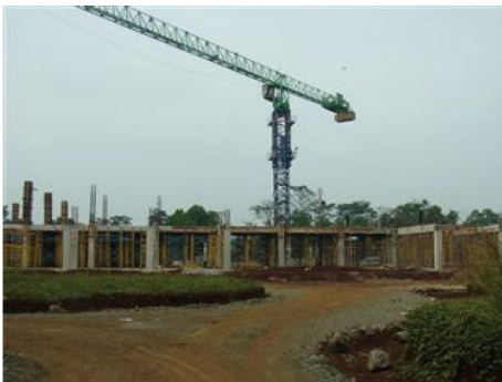
MCCOE 建設現場
