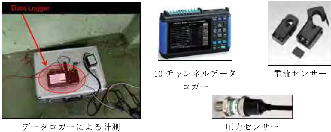
図 5-42 データロガーを使用した空気圧縮機の運転状況計測
