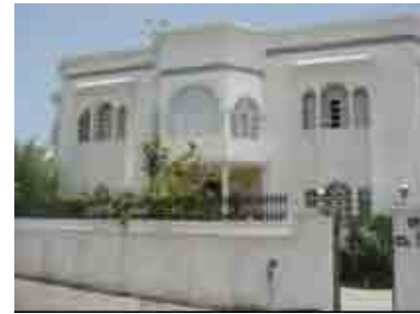
図 5-64 住宅 B の外観
